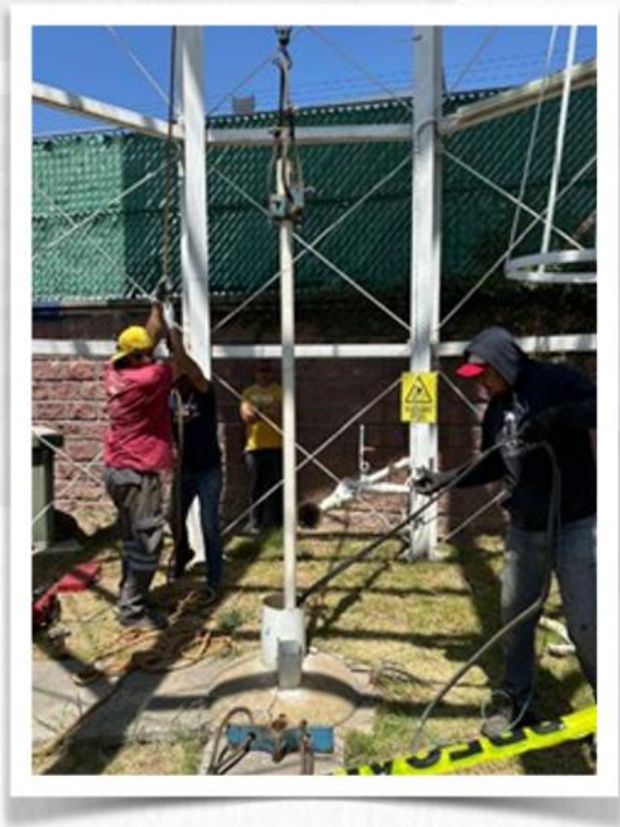
Imágenes 4.22 Mantenimiento a pozos. Fuente: SOSAPACH
