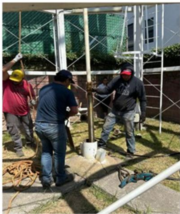
Imágenes 4.23. Mantenimiento a pozos. Fuente: SOSAPACH
