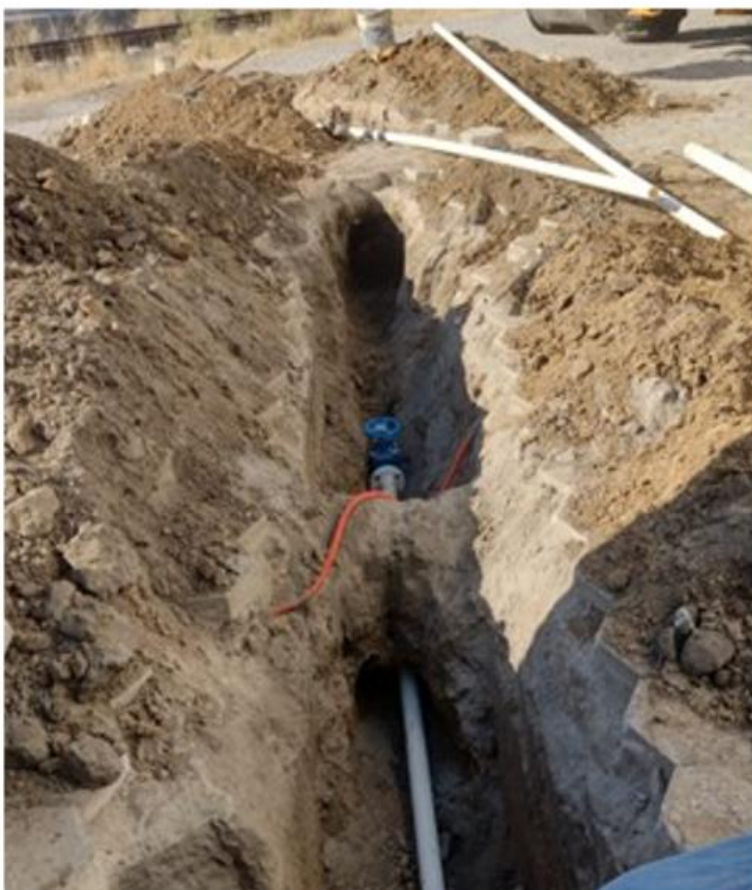
Imágenes 4.26. Mantenimiento a pozos. Fuente: SOSAPACH
